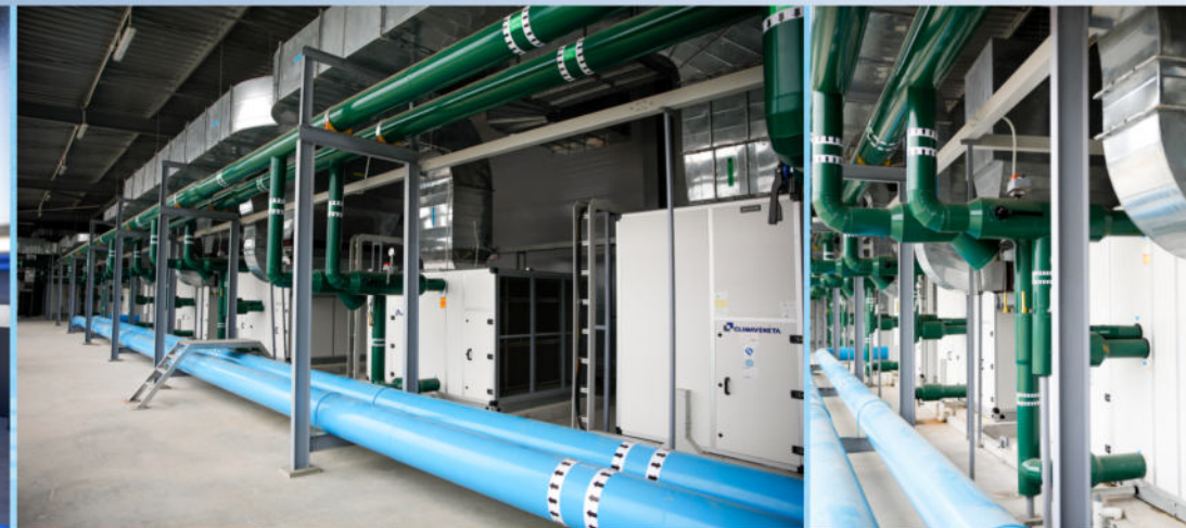
THỰC TẾ THI CÔNG HỆ THỐNG HVAC
