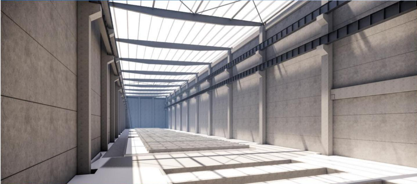
3 D 模型：预制混凝土柱子设计，预制混凝土墙板设计
