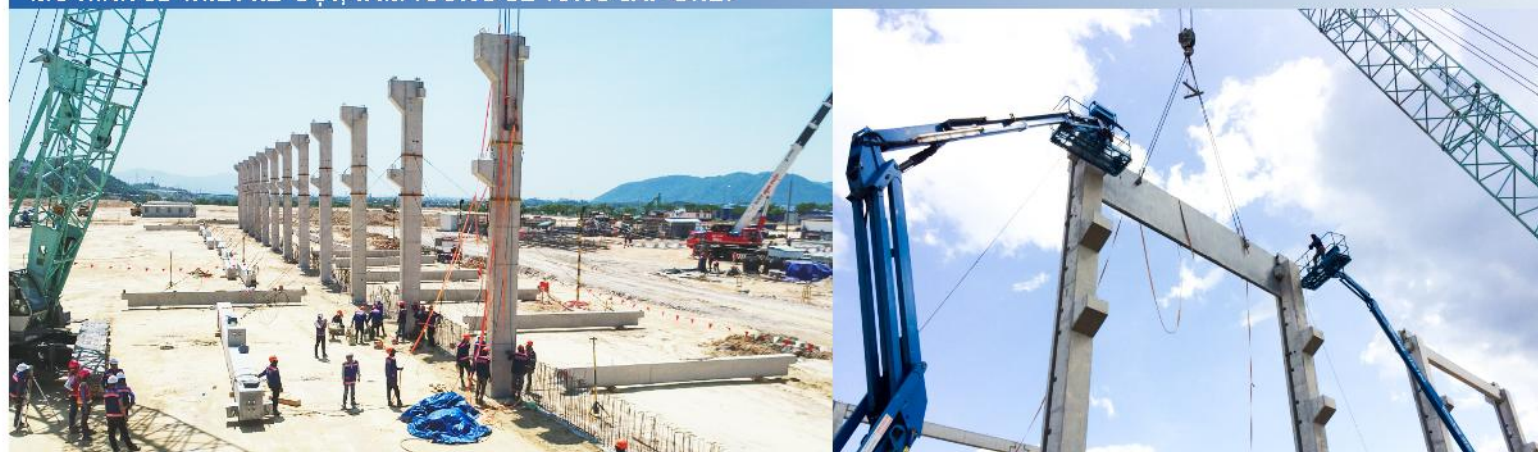
LẮP DỰNG CỘT, TẮM TƯỜNG BÊ TÔNG LẮP GHÉP
