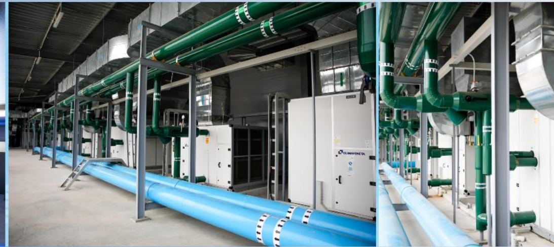
THỰC TẾ THI CÔNG HỆ THỐNG HVAC
