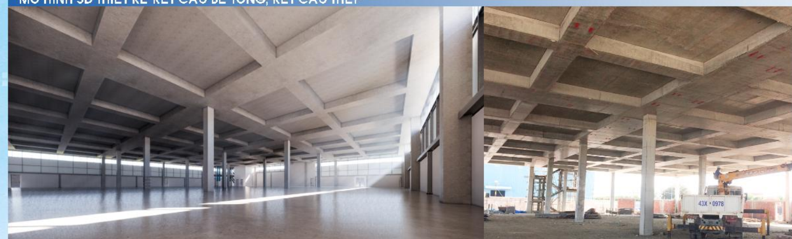
MÔ HÌNH 3D THIẾT KẾ KẾT CẤU SÀN DỰ ỨNG LỰC
