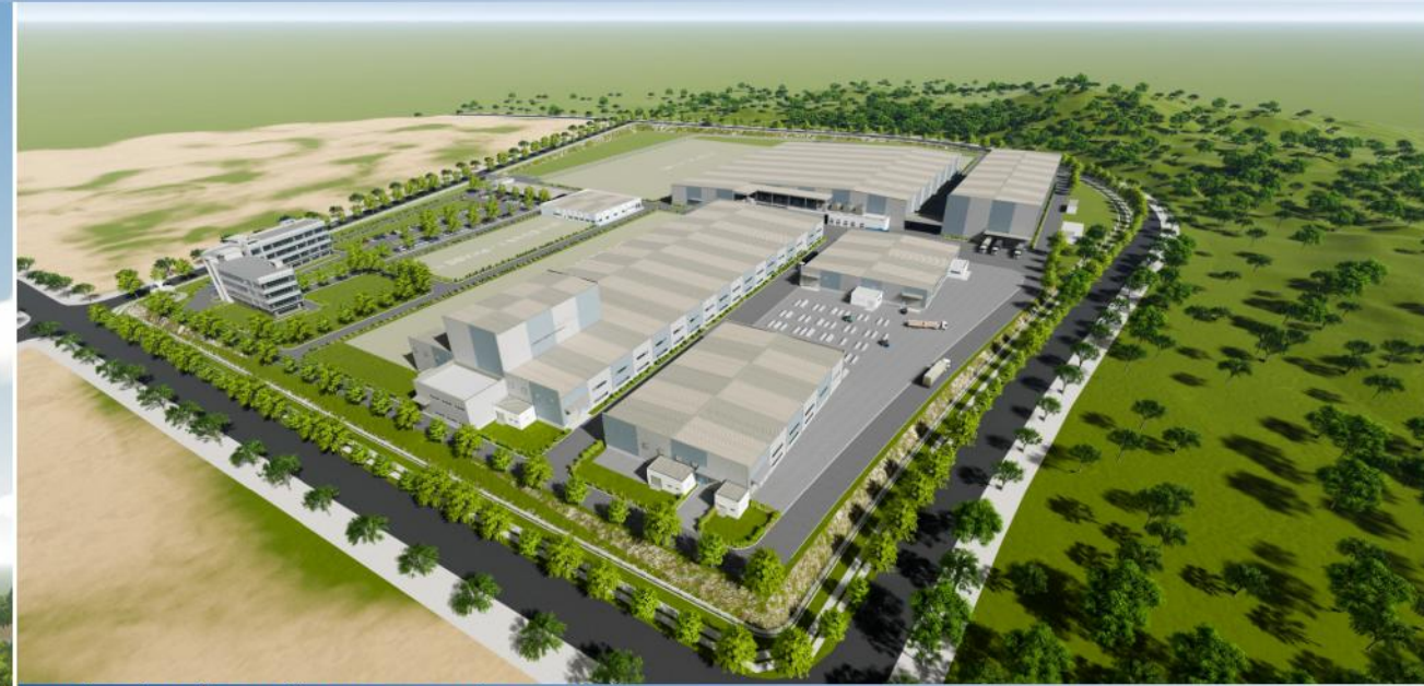
NHÀ MÁY SẢN XUẤT LINH KIỆN HÀNG KHÔNG VŨ TRỤ SUNSHINE
