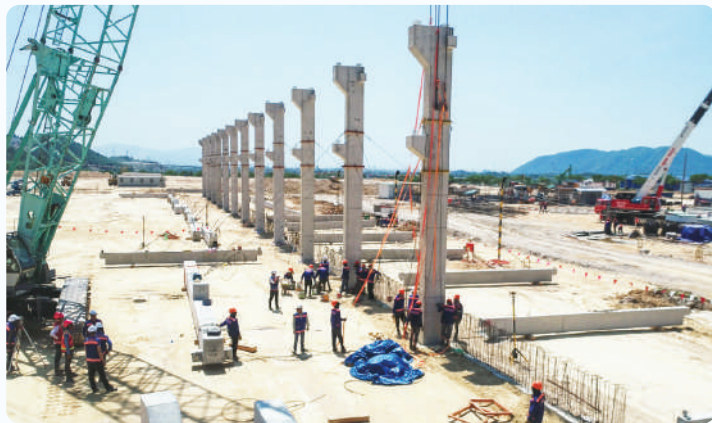
Lắp dựng cột, tấm tường bê tông lắp ghép
