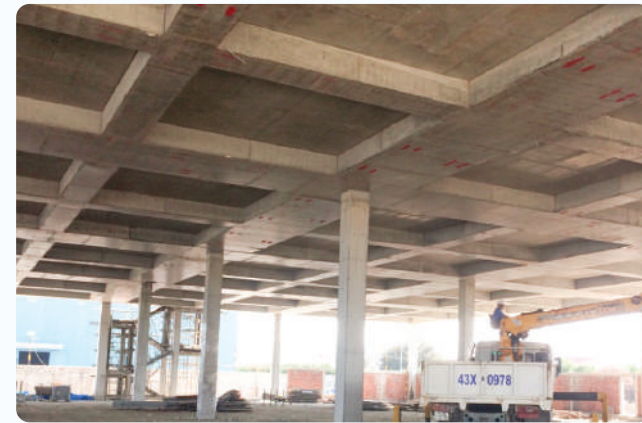
Thực tế thi công
