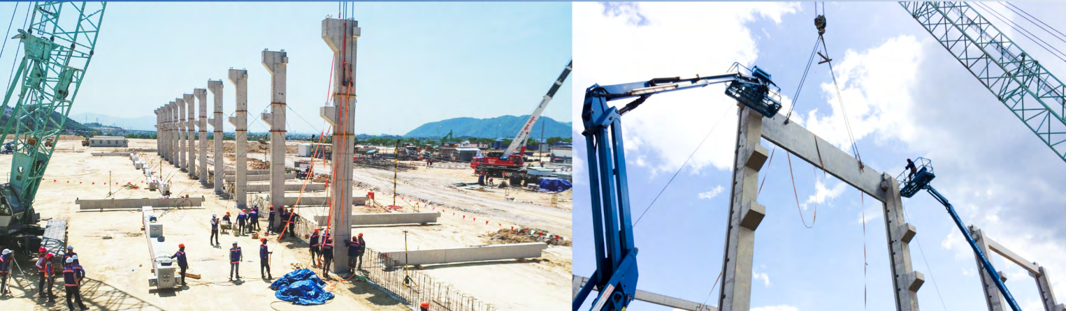
LẮP DỰNG CỘT, TẮM TƯỜNG BÊ TÔNG LẮP GHÉP
