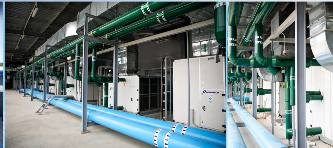
THỰC TẾ THI CÔNG HỆ THỐNG HVAC
